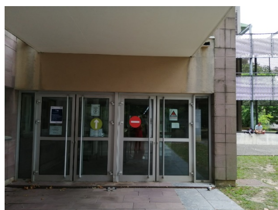
Entrée extérieure (photo 2)
